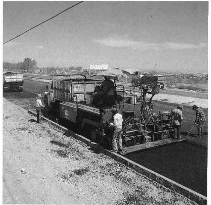
Colocación de carpeta asfáltica en el camino Jarudo-Glorieta.
